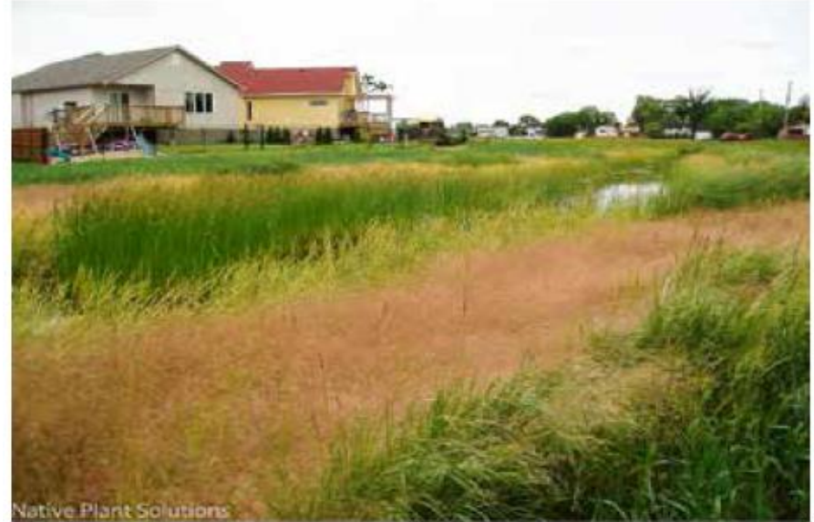
Rigole de drainage biologique (“Bioswale”)
