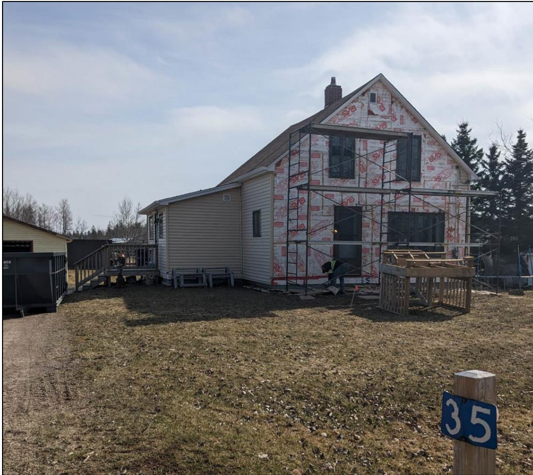
35 chemin Trois Ruisseaux – maison unifamiliale existante (17 avril 2023)
