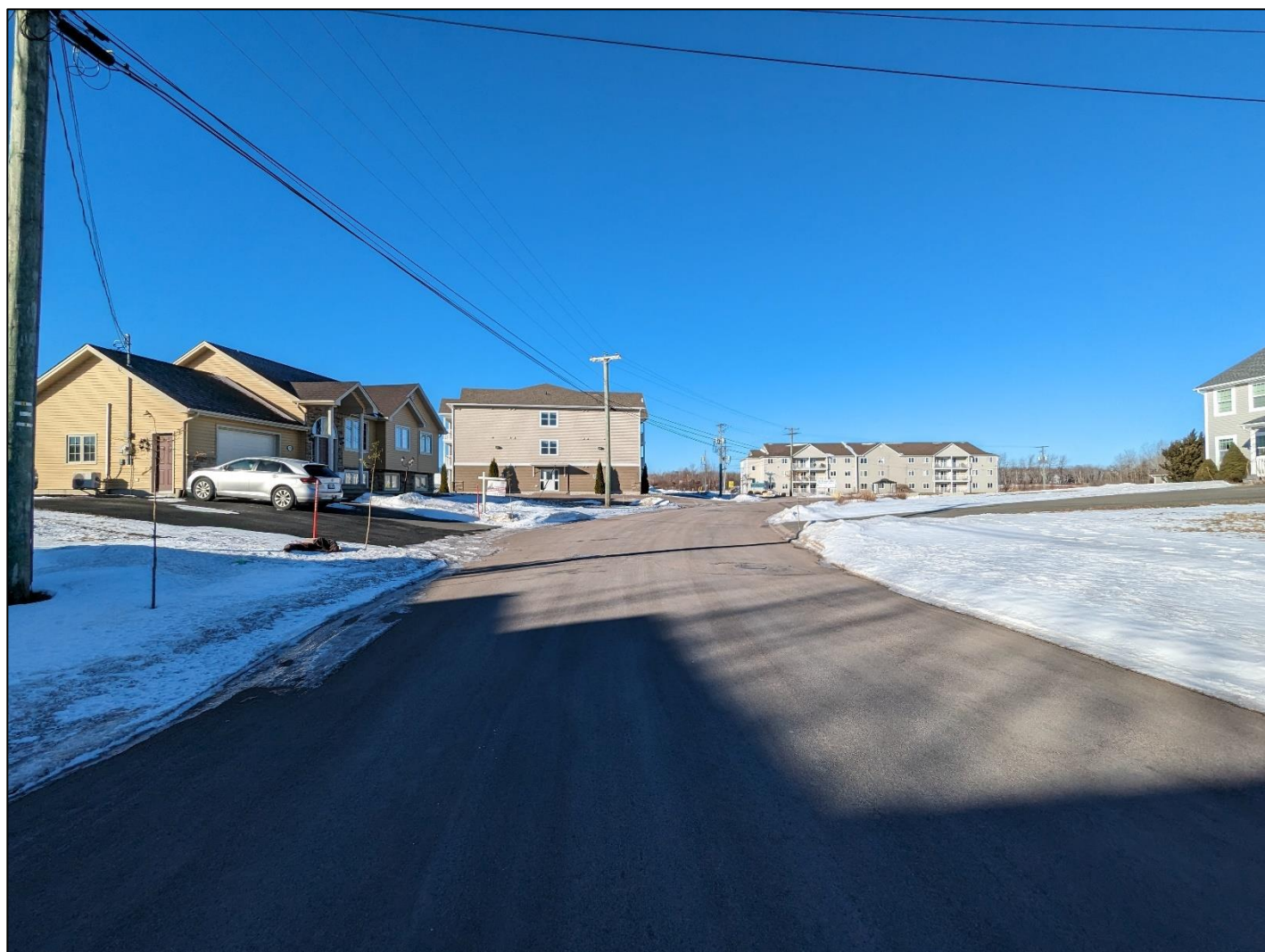
Roy Mollins Drive – West view of the existing built environment / Vue ouest de l'environnement bâti existant
