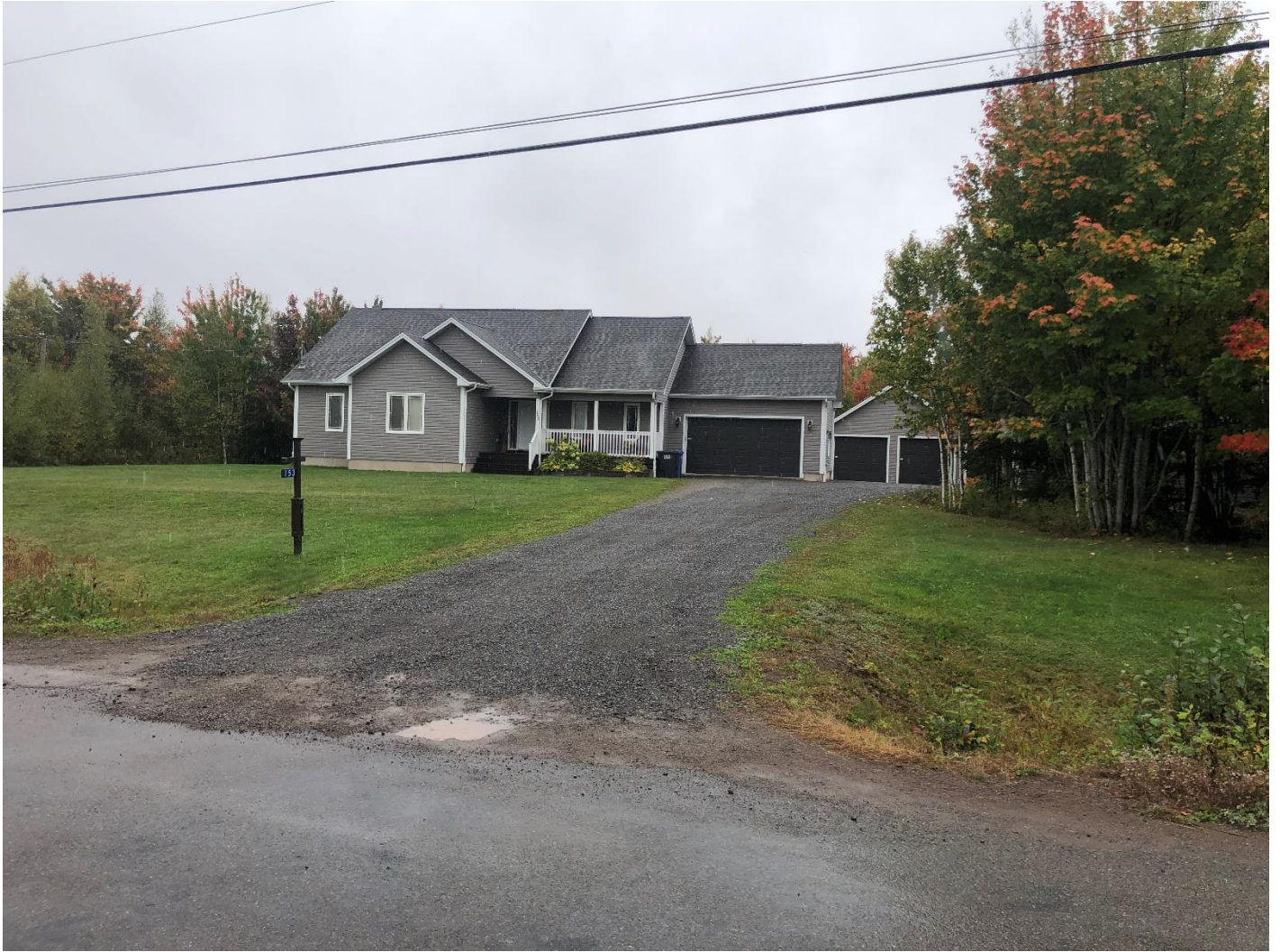
Driveway to subject property and garage at rear / Entrée de la propriété en question et garage en arrière
