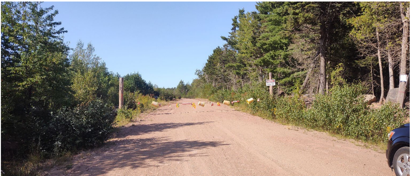
Point d'accès à la route non maintenu/ access point to the non maintained road
