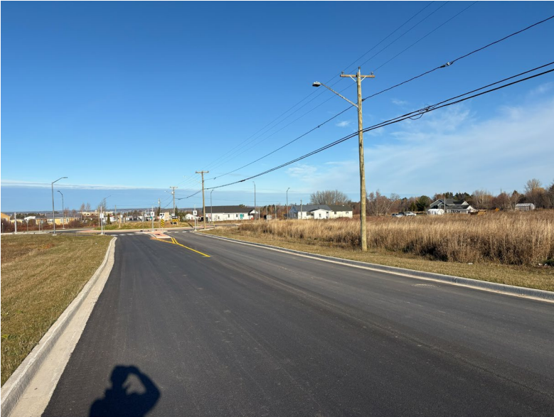
Photo du site – 21 novembre 2025 / Site Photo November 21, 2025
