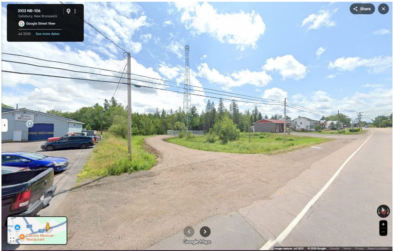
Frontage of Lot 26-1 on Main Street / Façade du Lot 26-1 sur la rue Main
