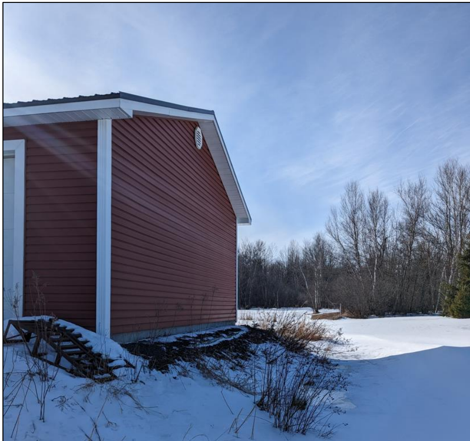
Side of existing accessory building / Côté du bâtiment accessoire existant
